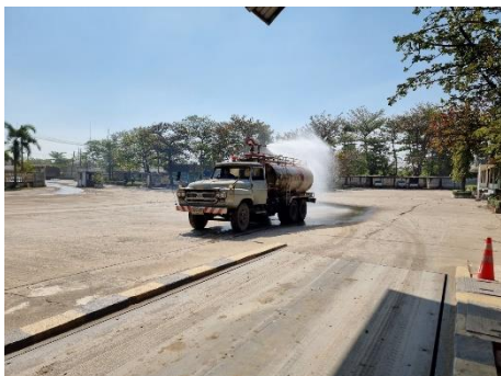
ภาพที่ 2.2-18 การฉีดพรมน้ำบริเวณเส้นทางขนส่งภายในโครงการ
