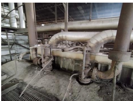
Bypass Valve วาล์วลดความดันของไอน้ำ
