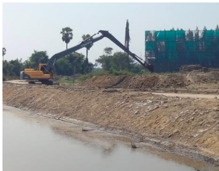
ภาพที่ 2.2-29 การขุดลอกตะกอนและกำจัดวัชพืช บริเวณรางระบายน้ำเสีย
