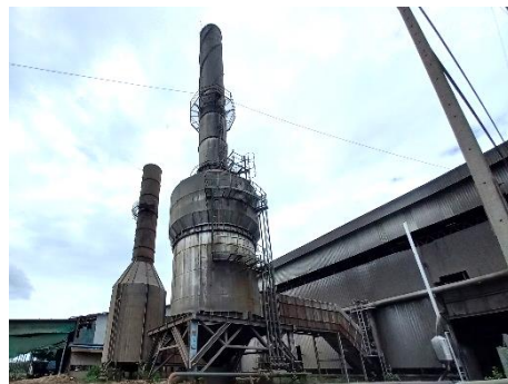
ภาพที่ 2.2-1 ปิ่มสำรองสำหรับระบบควบคุมมลพิษอากาศ (Wet Scrubber)
