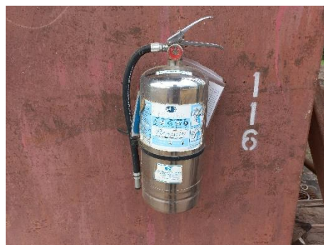
ถังดับเพลิงเคมีสูตรน้ำ
