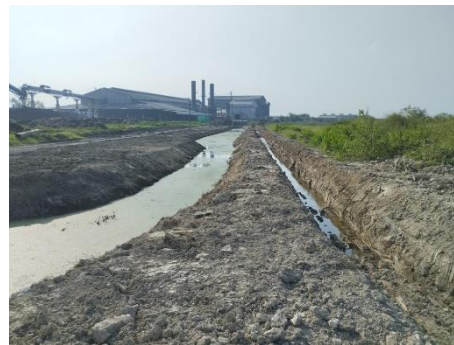
ภาพที่ 2.2-29 การขุดลอกตะกอนและกำจัดวัชพืช บริเวณรางระบายน้ำเสีย
