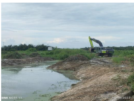
ภาพที่ 2.2-30 การขุดลอกตะกอนและกำจัดวัชพืช บริเวณบ่อบำบัดน้ำเสีย
